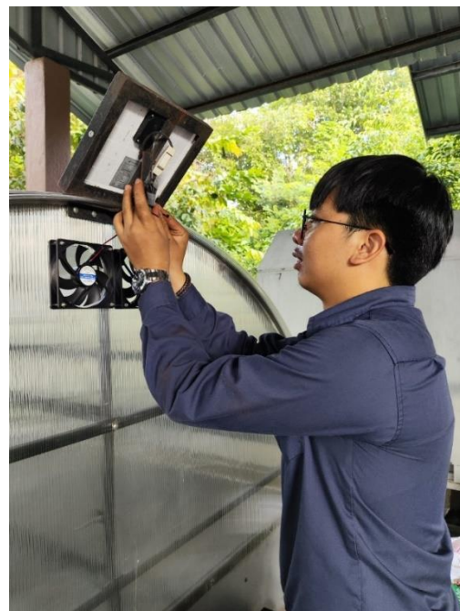
ภาพ ก.1 (ก) เชื้อทำความสะอาดแผ่นโพลีคาร์บอเนต (ข) ประกอบสายไฟเพื่อป้อนหลอดความร้อนเสริม (ค) ตัวควบคุมระบบความร้อนเสริม (ง) ติดตั้งพัดลมระบายความร้อน
