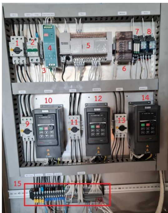
ภาพ ก.17 อุปกรณ์อิเล็กทรอนิกส์ต่างๆ ภายในวงจรควบคุมการทำงาน
