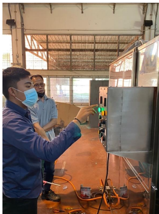
การทดสอบตู้ควบคุมเครื่องอบแห้ง
