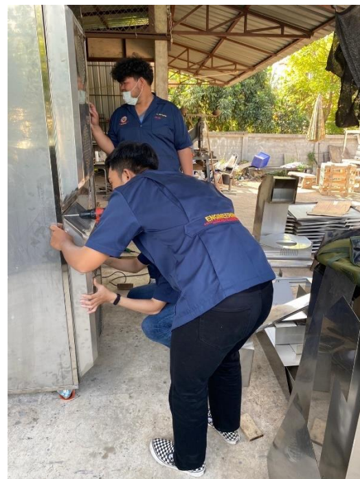
ติดตั้งพัดลมดูดอากาศชุดที่ 2
