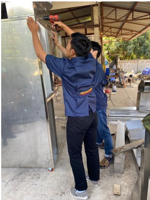
ติดตั้งพัดลมดูดอากาศชุดที่ 1
