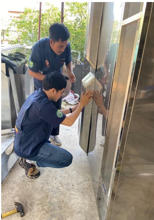
วางตำแหน่งฝาครอบพัดลมดูดอากาศ
